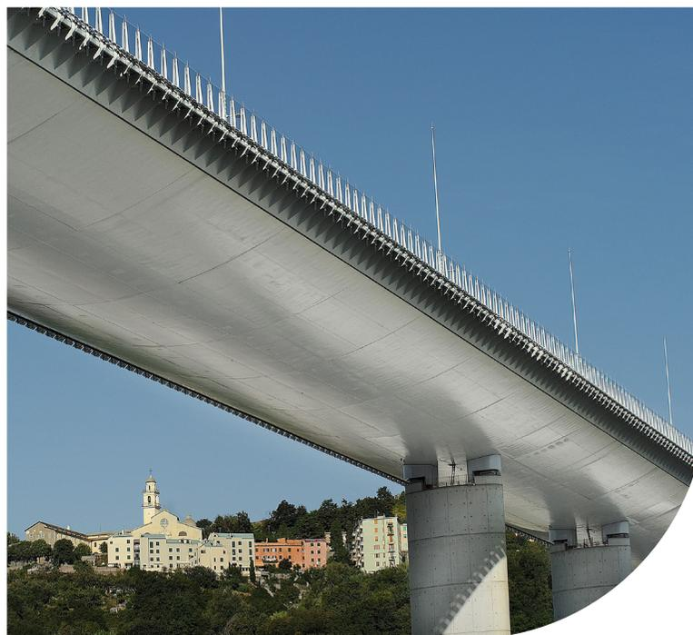
Pour la reconstruction du pont de Gênes en Italie, Heidelberg Materials a utilisé du ciment contenant environ 40 % de matières recyclées et dont l'empreinte carbone est nettement plus faible.
