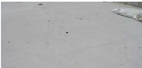
Figuur 2: Krimpscheuren
