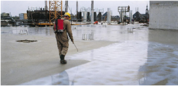
Figuur 3: Verstuiven van "curing compound"
