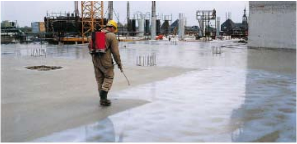
Figure 3 : Pulvérisation d'un 'curing compound'
