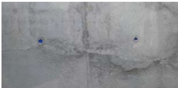
Figure 1 : Reprise de bétonnage dans un mur
