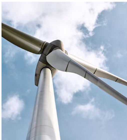
Fin 2021, CBR Gand sera alimentée par l'énergie éolienne. ©Luminus
