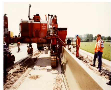
Figuur 7.18b Slipformpaver voor voertuigkeringen
