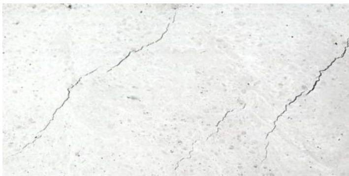
Plastische krimpscheuren in beton
