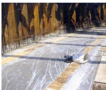
Nabehandelen door afdekken met folie
