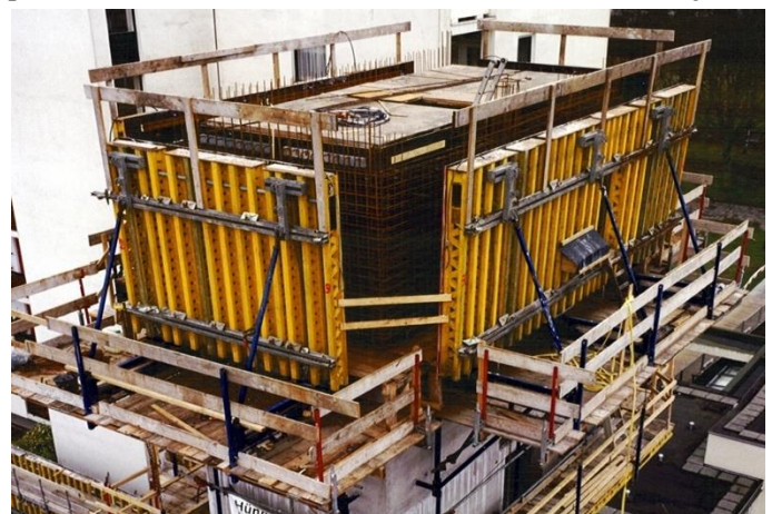
Figuur 6.4 Systeembekisting
