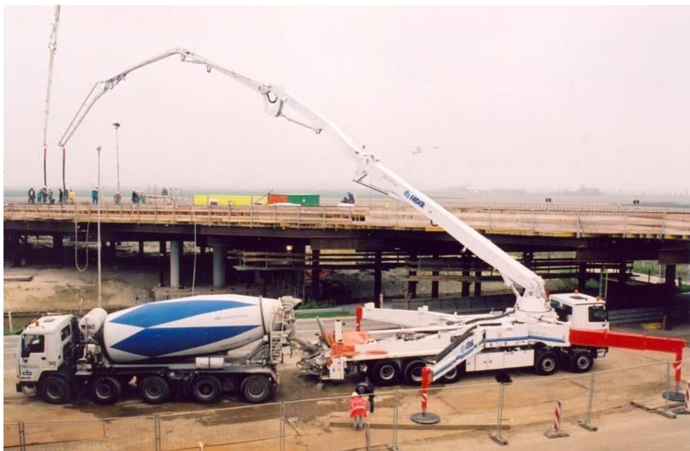
Figuur 7.5 Mobiele pomp aan het werk.
