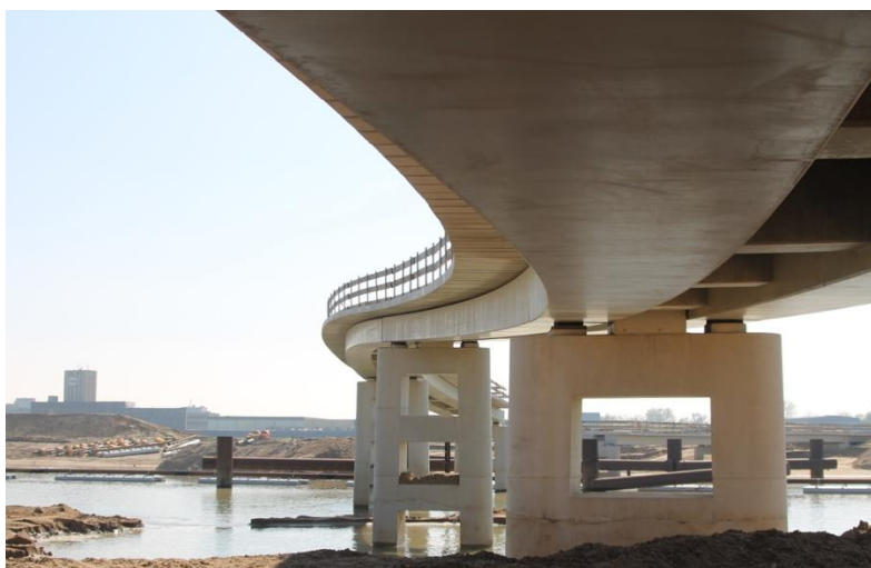
Figuur 1.3 Betonnen brug in Nijmegen (Fotografie Spanbeton)
