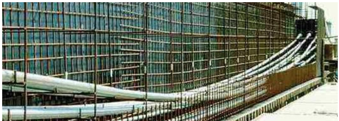
Figuur 6.5 Omhullingsbuis en verankeringen.
