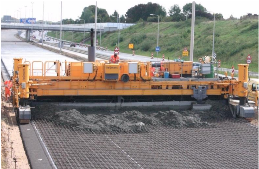
Figuur 7.17a Slipformpaver
