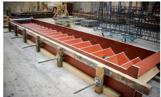
Een mal voor een betonnen trap
