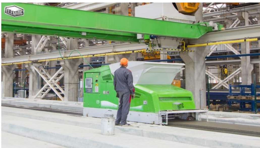
Figuur 5.6 Storten en afwerken van kanaalplaten vervaardigd volgens de lange-bank methode. (bron: Elematic)
