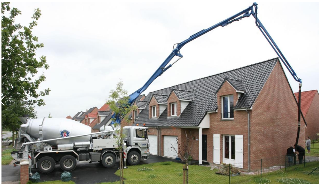
Figuur 7.6 Truckmixerpomp. (Bron: Putzmeister)
