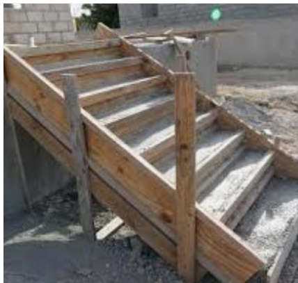
Dit is natuurlijk ook een bekisting
