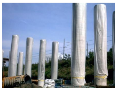
Nabehandelen door afdekken met folie
