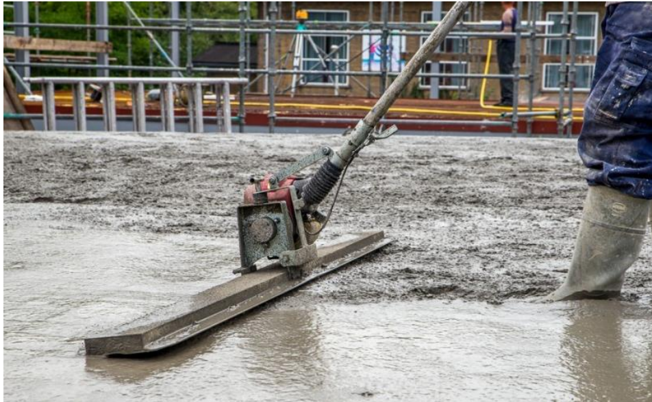
Figuur 7.10 Verdichten van betonspecie met een trilbalk. (Bron: De Poort Praktijkschool)
