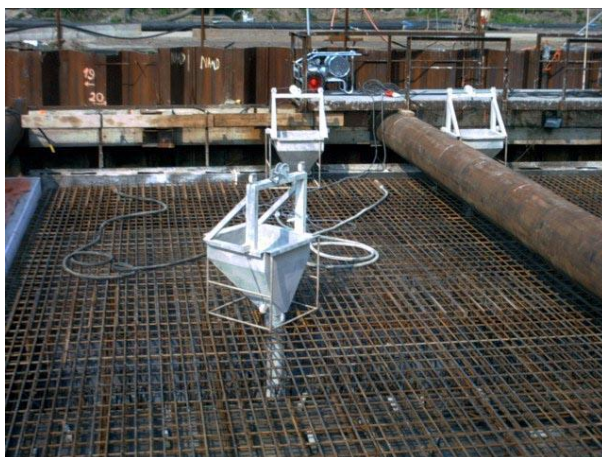
Figuur 7.7 Stortkoker bij een dikke vloer.
