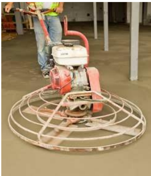
Figuur 7.13 Machine voor afwerking van een betonvloer.
