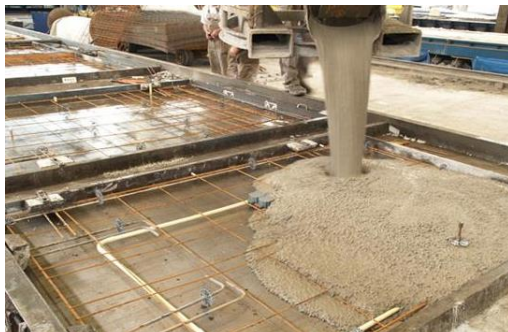
Een mal voor een wandelement
