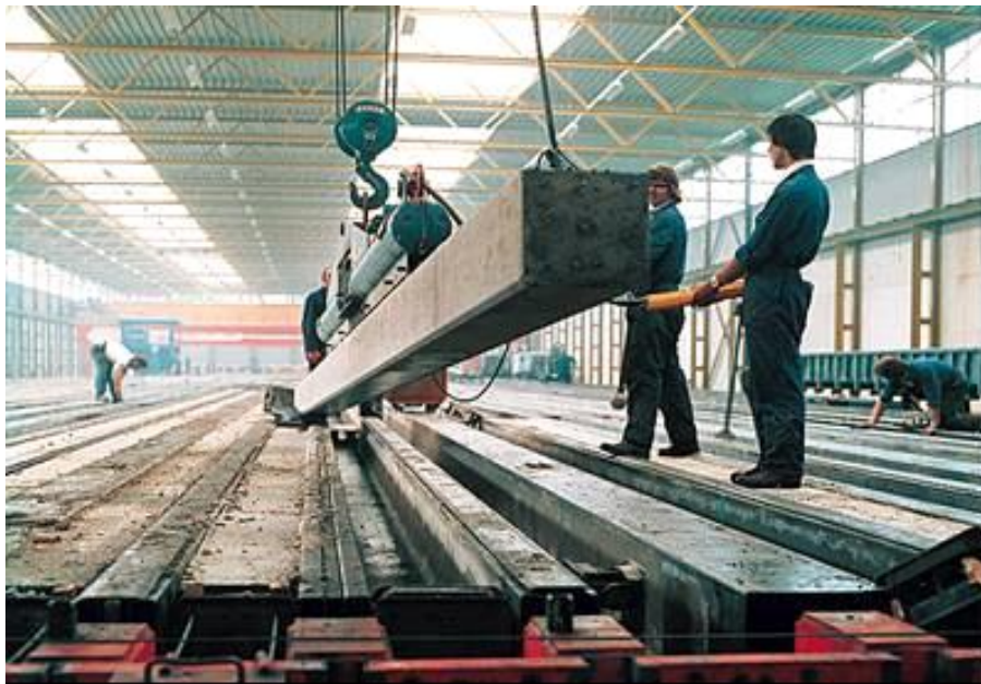
Figuur 5.5 Groot betonelement (heipaal) vervaardigd met de lange-bankmethode.
