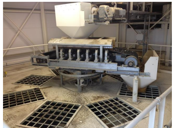
Het vullen van de dagbunkers boven de menger
