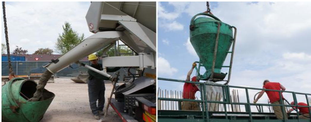
Figuur 7.3 Kantelkubel tijdens het vullen (horizontale stand) en tijdens storten (verticale stand). (Bron: VOBn)
